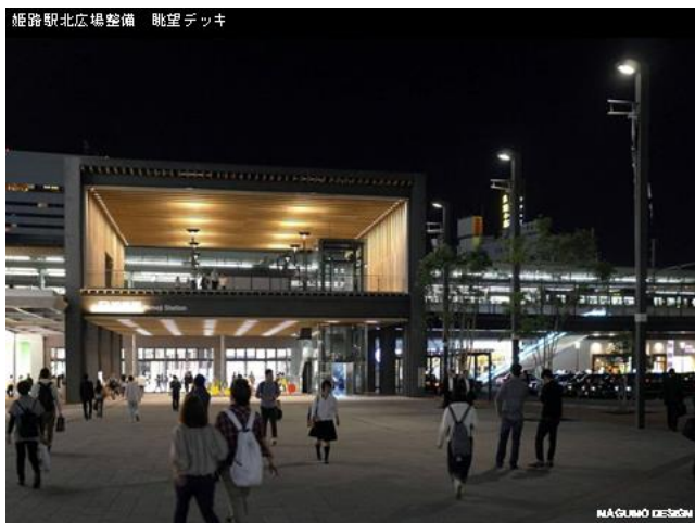
姫路駅北広場整備 眺望デッキ
