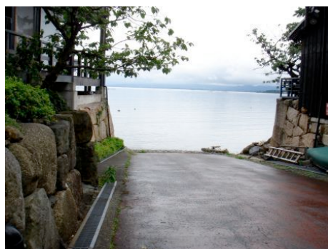
▲ 住民によってつくられた生活道
